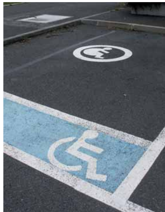
La signalisation des places de parking réservées aux handicapés est progressivement améliorée avec une peinture bleue au sol en plus du panneau réglementaire.
