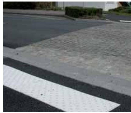
Les bandes podotactiles permettent avec un très léger relief de signaler un passage piéton aux personnes mal-voyantes. L'abaissement au niveau de la rue facilite la montée et la descente des trottoirs.
